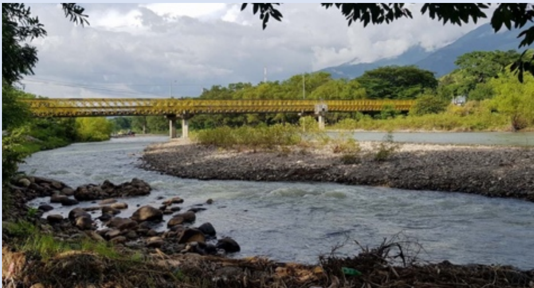
Fotografía del destino
